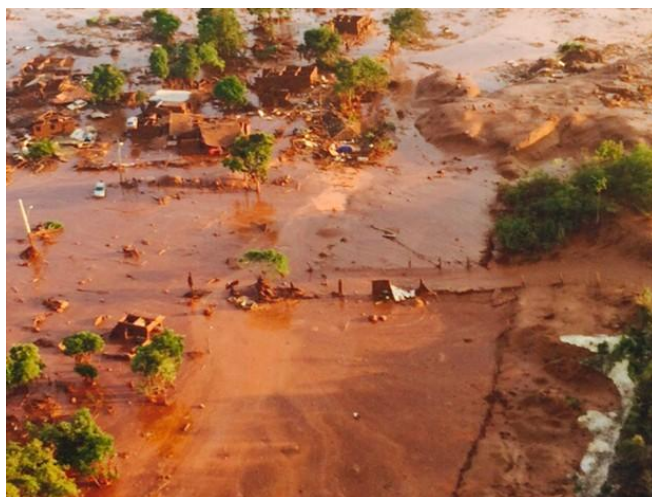
Rompimento da barragem de Fundão, em Bento Rodrigues (Foto: Luis Eduardo Franco/TV Globo)
