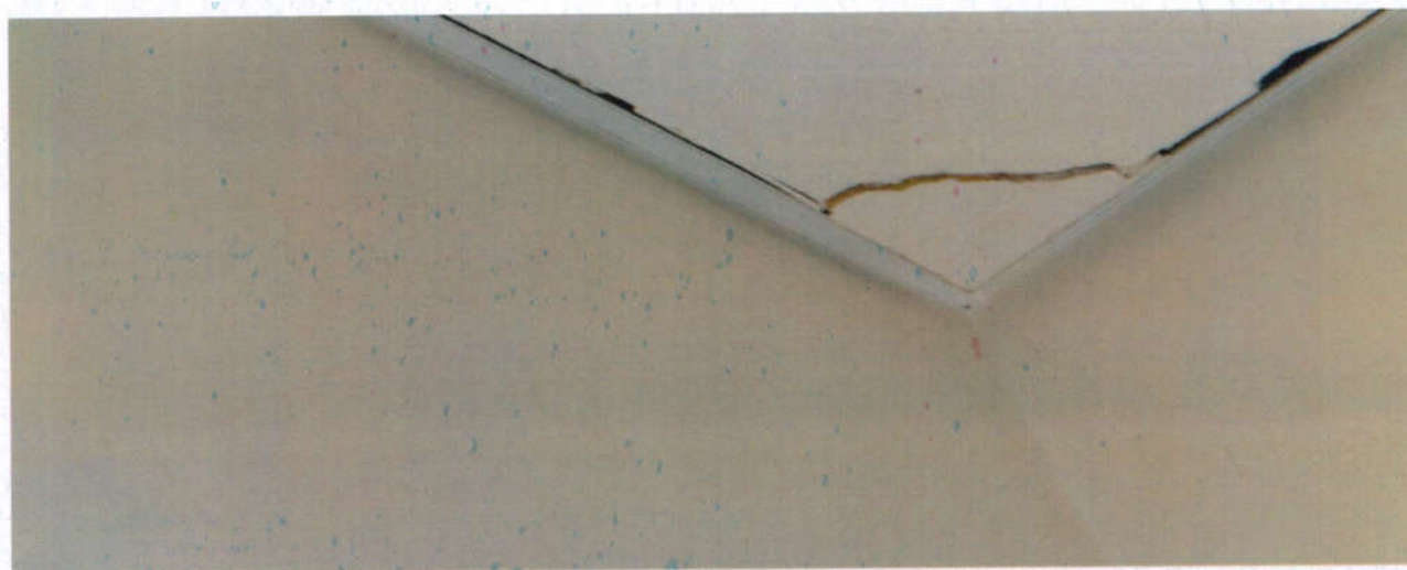
TRINCOS NA LAJE DE GESSO
